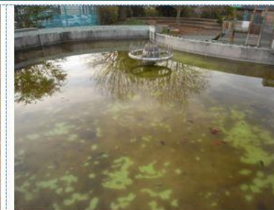
Vue 8 – bassin haut
