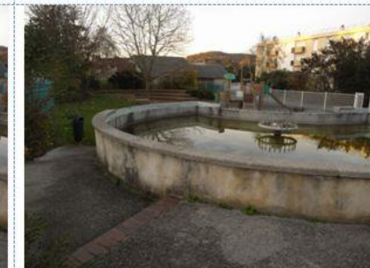
Vue 6 – bassin haut
