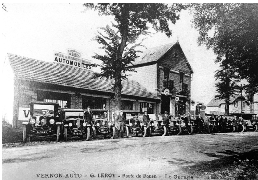
Le garage Ford de monsieur Leroy depuis la route de Rouen.
