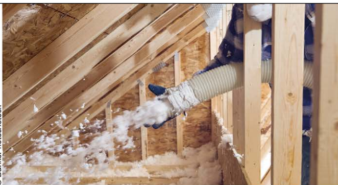
Réduction de 30% de la facture de chauffage en isolant les combles.
