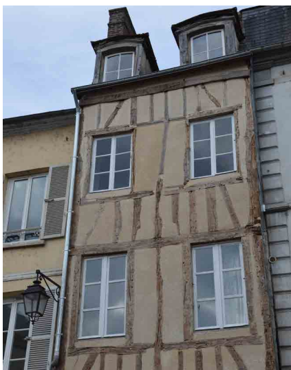
Cette façade à pans de bois avait été recouverte à l'époque. Elle a récemment retrouvé son aspect originel et historique.
