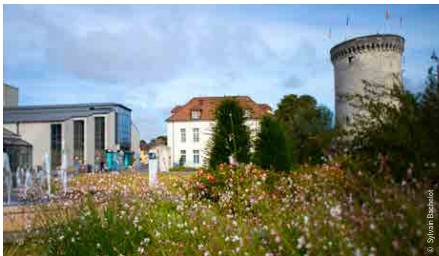
Au début du 19 e siècle, la Tour des Archives a failli être détruite en raison de son mauvais état. Finalement, l'une des rares rescapées de l'ancien château-fort a pu rester debout.
