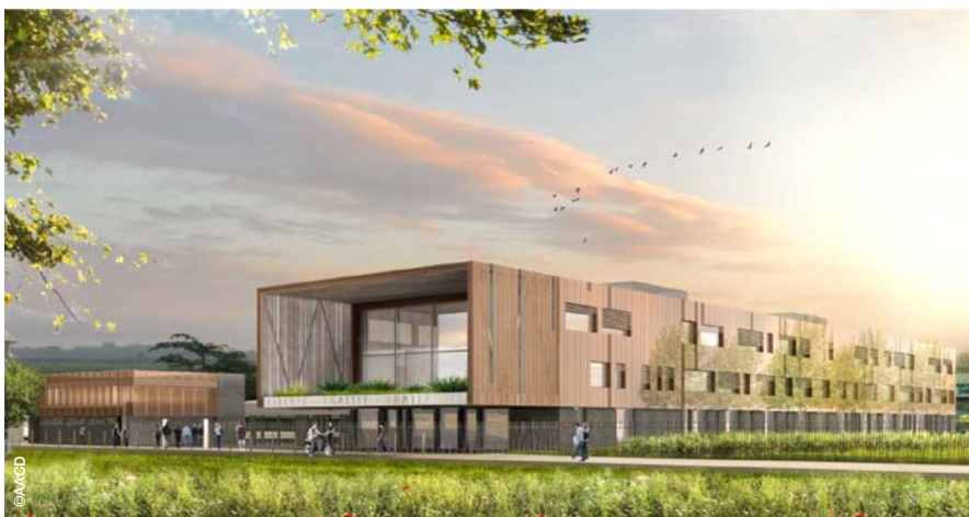
La proue du bâtiment, habillée d'un alliage de cuivre donne un aspect moderne au futur collège.
