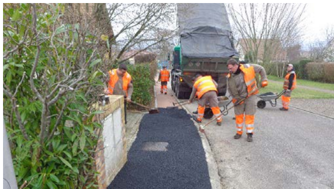
Rue Jean-Ourry à Bizy, le trottoir a été refait à la demande des riverains.
