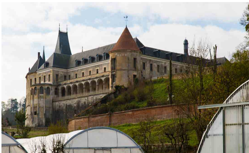
Les serres sont maintenant proches du château de Gaillon.
