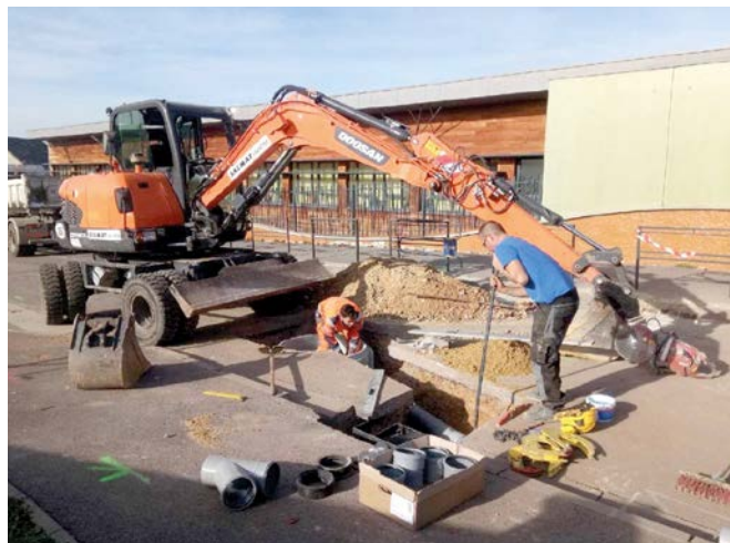
Parmi les nombreux travaux de voirie décidés par la ville, une bonne partie concerne l'entretien des réseaux souterrains.
